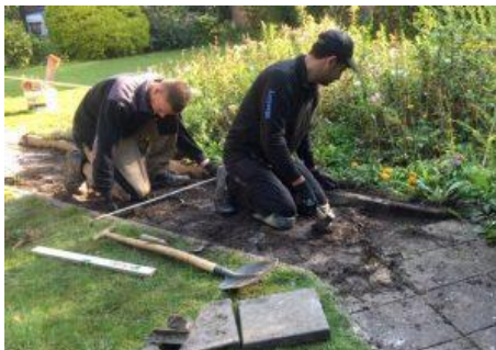
Het tegelpad wordt opnieuw gelegd
