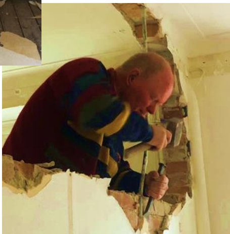
Jan houdt alles in de gaten – ook de leidingen
